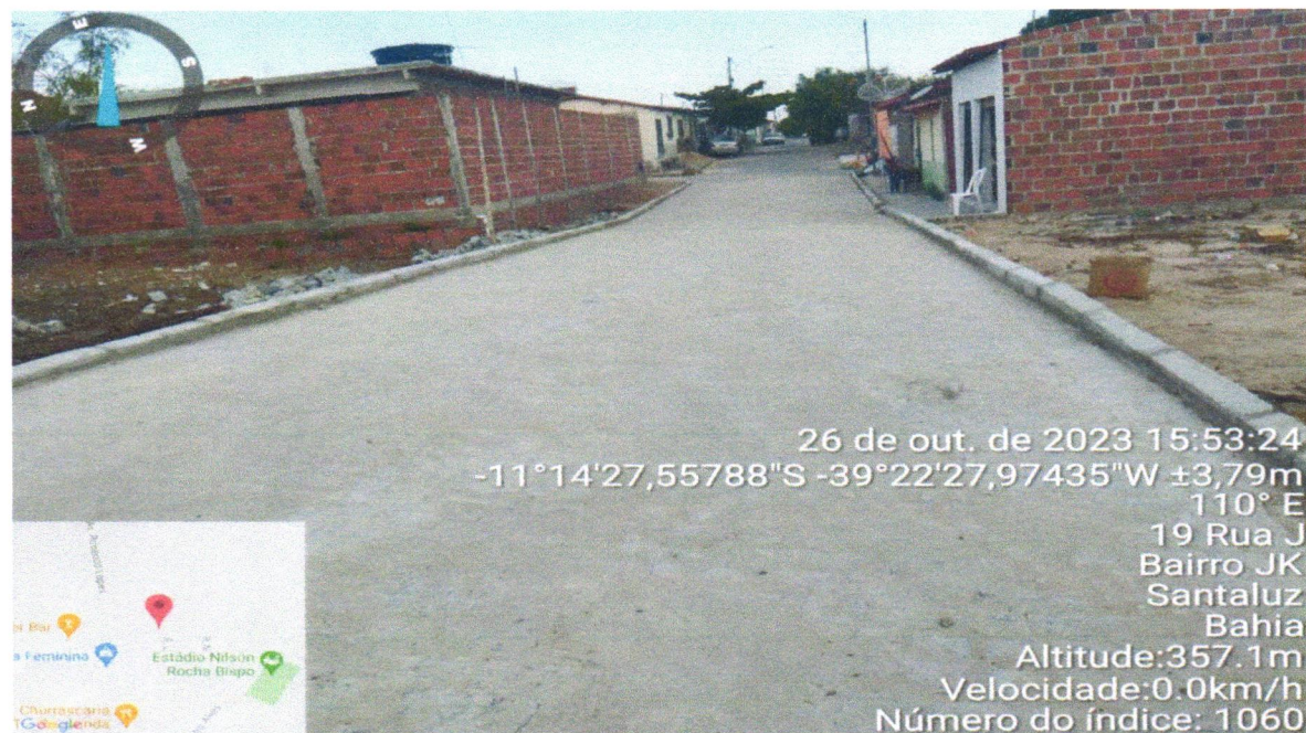
Execução de Pavimentação do Bairro JK, Rua Projetada 03
